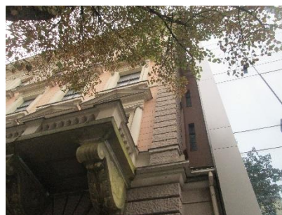
37.att. Fasāde no Stabu ielas piekļuves.
