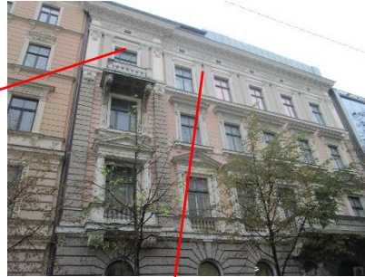
33.att. Ielas fasādes fragments.
