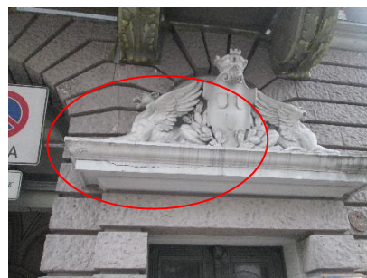
34.att. Ielas fasādes fragments.
