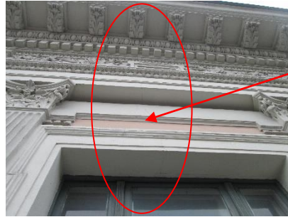
32.att. Ielas fasādes fragments.
