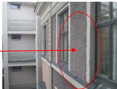
31.att. Ielas fasādes fragments.
